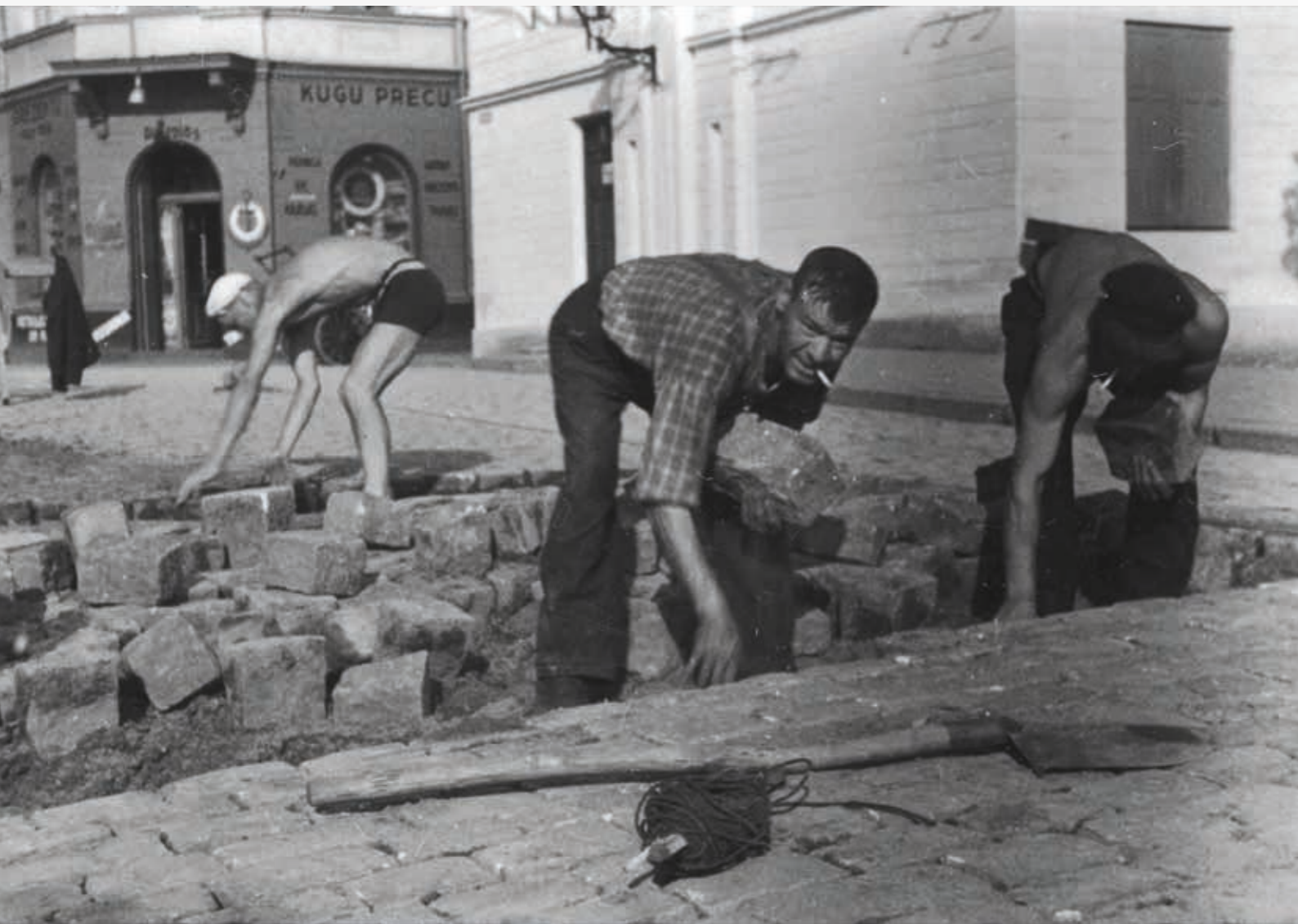
In Riga/Lettland beim Straßenbau (links) und in Reval (Tallin)/Estland im Hafen (rechts)
